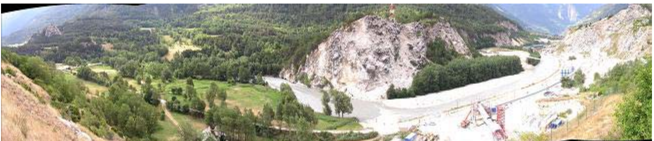
En Aval du pont de la Glair, le site du Moulin et le chantier de la descenderie.
